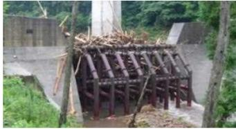
例:流木捕捉効果の高い砂防堰堤の設置
