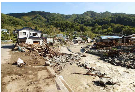
岩泉町 小本川上流 (被災直後)
