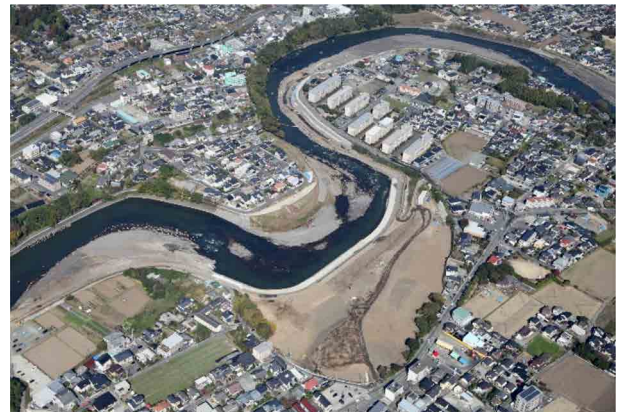
〔白川〕龍田陣内・下南部地区の河道付替(熊本市)
