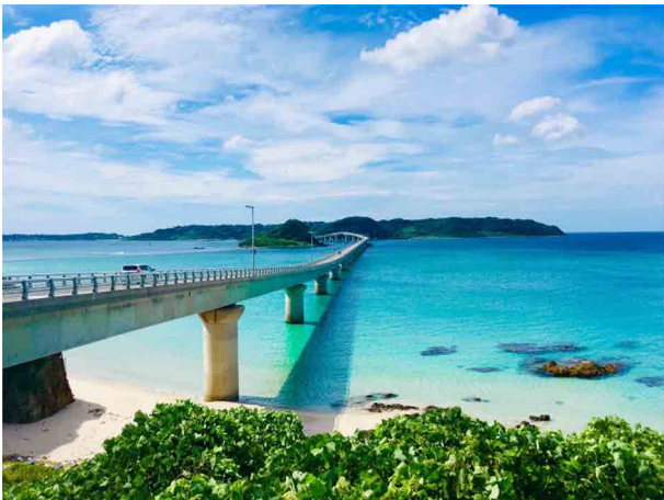
<角島大橋(下関市)>
