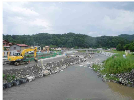
岩泉町 小本川下流（施工中）
