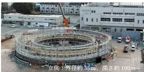
建設中の寝屋川北部地下河川(城北立坑)
