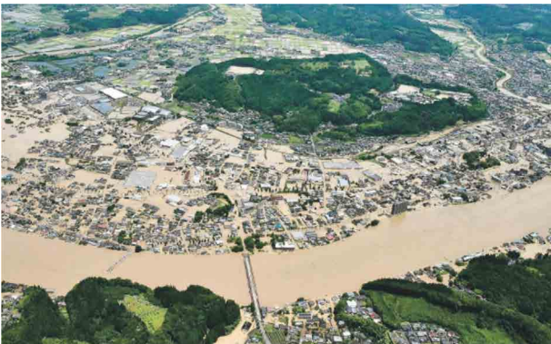
〔球磨川〕浸水被害状況(人吉市)
