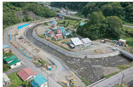
岩泉町 小本川上流 (施工中)
