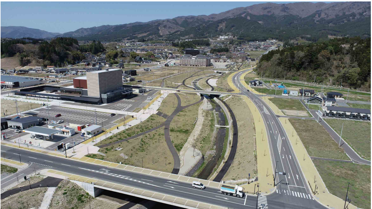
二級河川気仙川水系川原川・川原川公園（陸前高田市）
