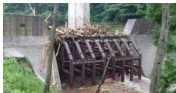
流木捕捉効果の高い砂防堰堤の設置
