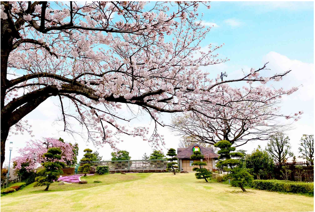
江戸川高規格堤防(スーパー堤防)柴又公園地区 柴又公園の整備と一体で高規格堤防の整備を行うことにより、 公園と水辺の連続性を図り、水と緑の豊かな憩いの場が提供されています。
