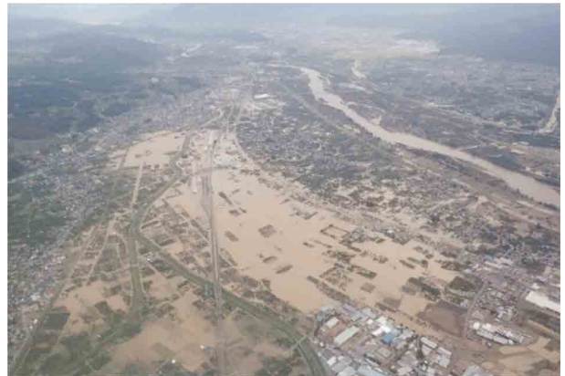
しなのがわ ちくま 堤防決壊の状況(信濃川水系千曲川)
