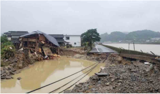
球磨川堤防の破損状況(熊本県人吉市 ひとよし )
