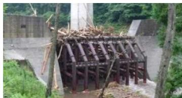
流木捕捉効果の高い砂防堰堤の設置
