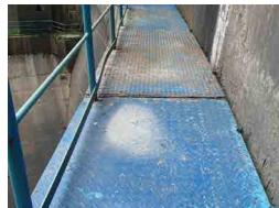
放流設備の改修(塗装、水密ゴム交換)
