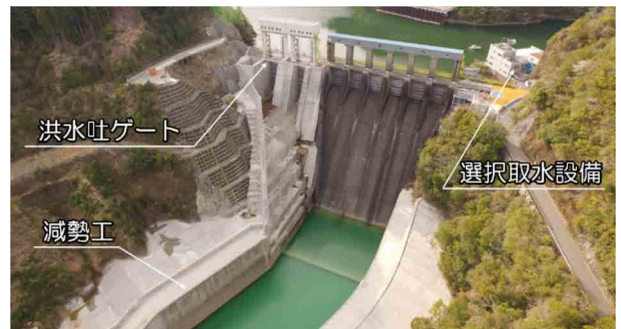
図2 長安口ダム本体改造工事概要
