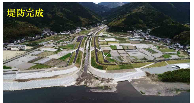
加茂堤防整備状況
