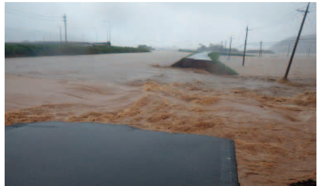
台風 18 号による野木川の破堤 (平成 25 年 9 月)
