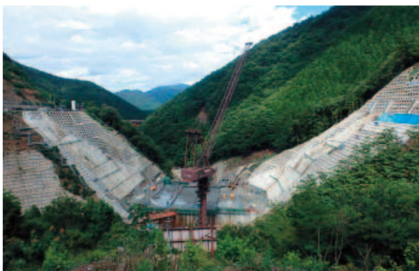
河内川ダム工事状況（若狭町）
