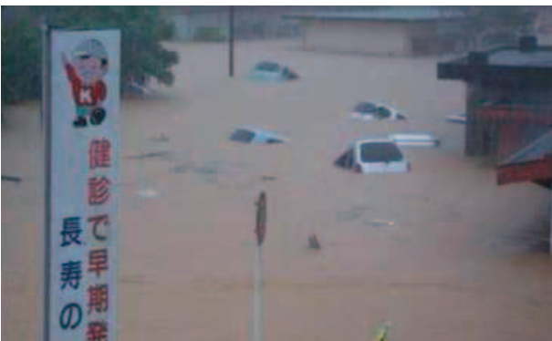
平成 22 年奄美豪雨災害による奄美市住用町の浸水被害
