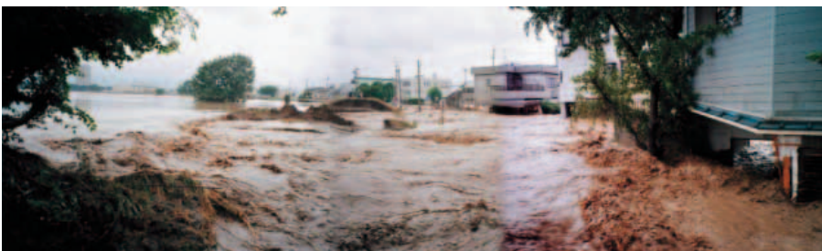
福井豪雨による足羽川の破堤 (平成 16 年 7 月)
