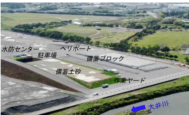
(図-5) 大井川川尻地区河川防災ステーション
