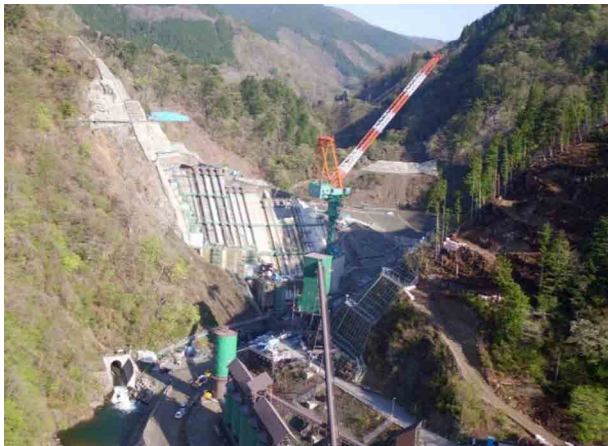
写真-1 内ヶ谷ダムコンクリート打設状況
