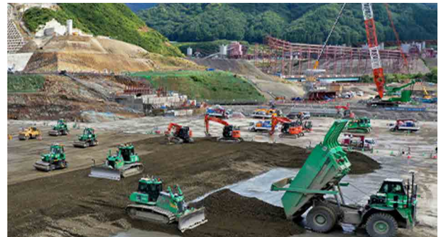
図-2 無人重機によるCSG打設
