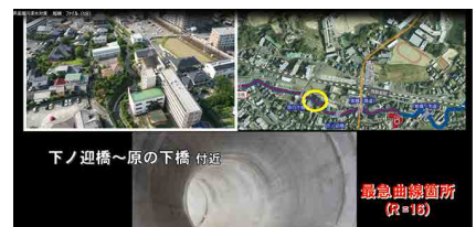
地下河川内部を運用開始前にドローン撮影した映像
