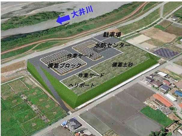
(図-4) 大井川中島地区河川防災ステーション
