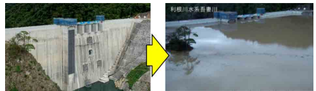
写真-3 ハッ場ダム貯留状況写真
