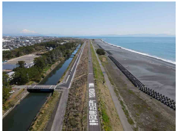
(図-7) 駿河海岸防潮堤(川尻工区)
