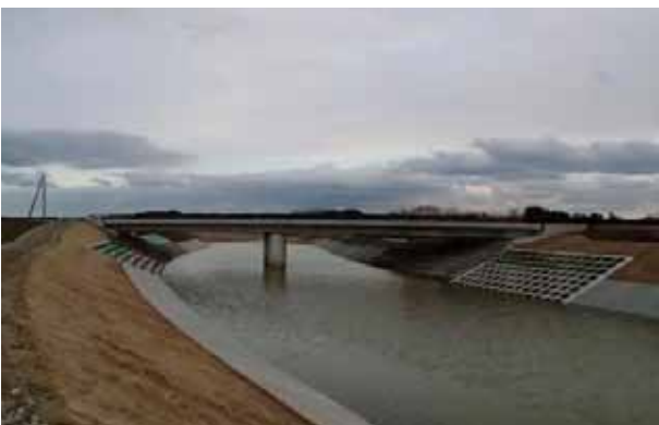
川内沢川放水路 竣工状況（名取市）【県施工】
