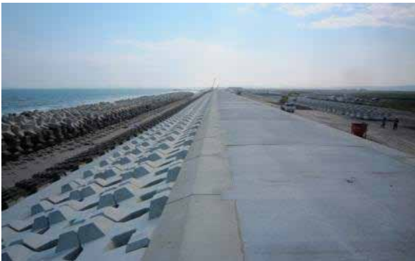
大曲地区海岸（東松島市）災害復旧工事状況【県施工】
