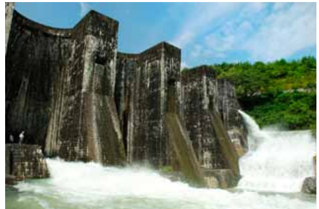
豊稔池（石積式 5 連マルチプルアーチダム）
