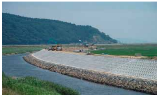
追波川(石巻市) 災害復旧工事状況【県施工】
