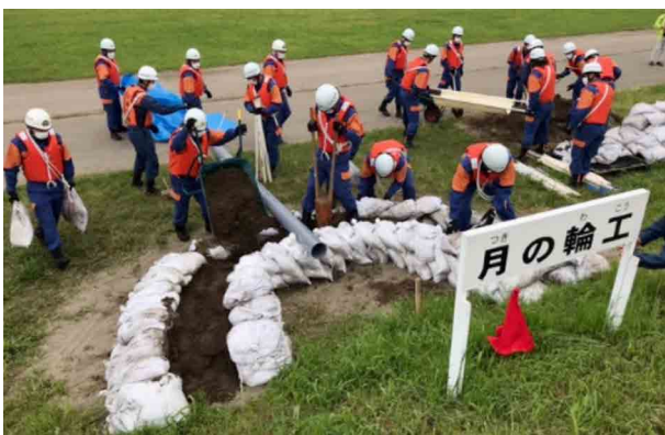
水防団による訓練(月の輪工) (第70回利根川水系連合・総合水防演習)
