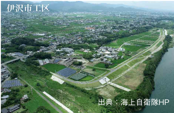
勝命堤防整備状況
