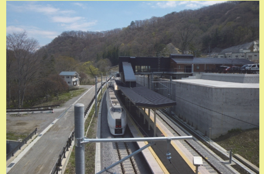
付替鉄道(川原湯温泉駅(新駅))(H27.4)
