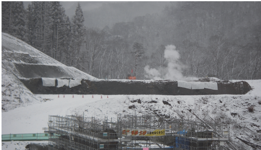
発破による掘削工事開始(ダム本体左岸) (平成27年1月22日撮影)
