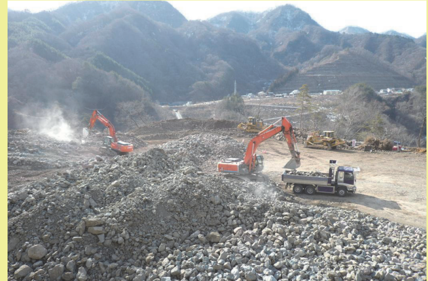
ダムサイト左岸掘削施工状況(H27.2)
