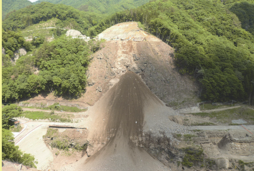
ダムサイト左岸掘削施工状況(H27.5)
