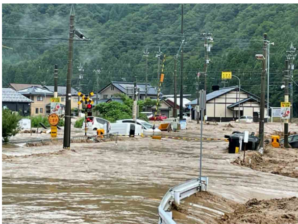
鹿蒜川の破堤(令和4年8月、南越前町提供)
