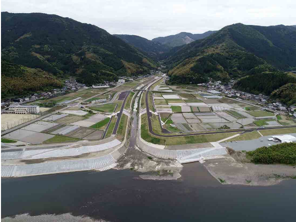
阿南市加茂地区 築堤状況(提供:那賀川河川事務所)
