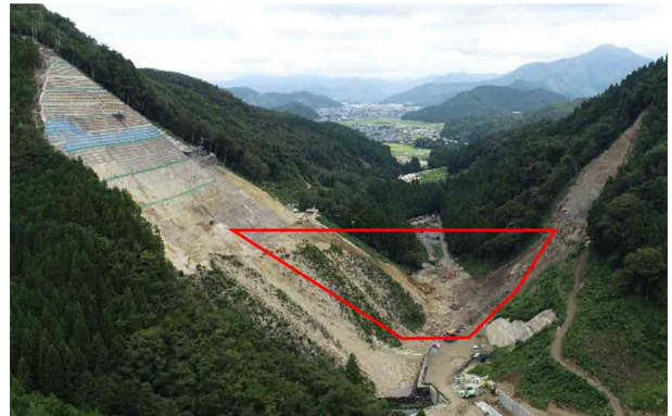
吉野瀬川ダム 上流よりダムサイトを望む (撮影日: 令和4年8月24日)
