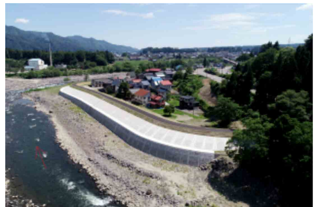
整備が進む信濃川(写真は段野田地区)
