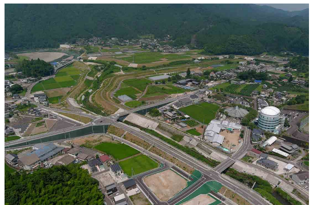
那賀町和食地区 築堤状況
