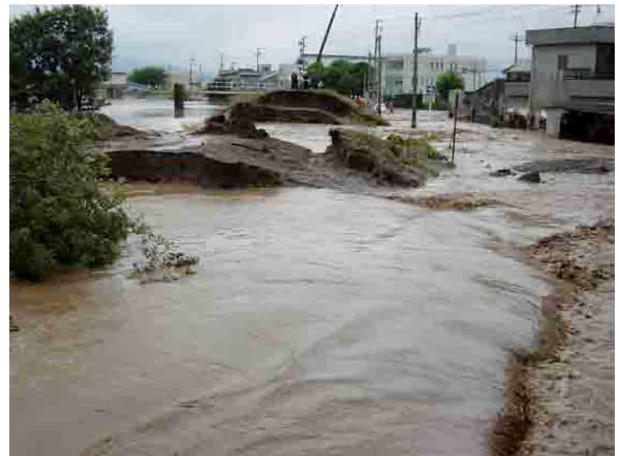
福井豪雨による足羽川の破堤(平成16年7月)
