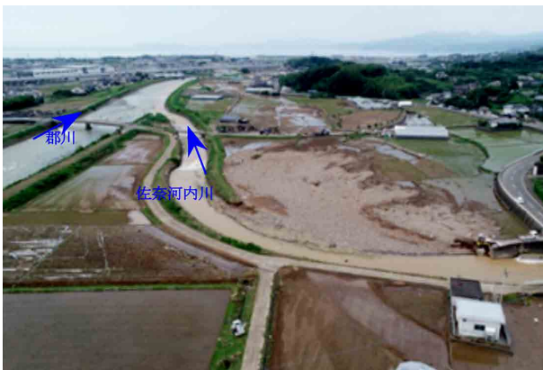
<佐奈河内川の被災状況>
