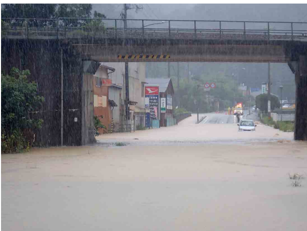
令和3年9月8日 海陽町 国道55号
