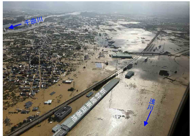
▲千曲川沿川の浸水状況(長野市)
