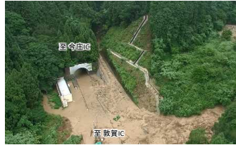
北陸自動車道 土砂流入 (福井県敦賀市)
