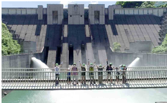
しぶき橋(管理橋)での記念撮影(長島ダム)
