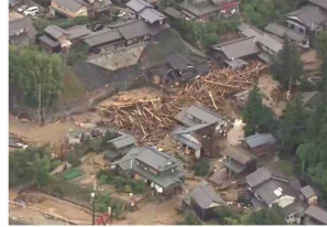
土石流等による被害 (新潟県村上市)
