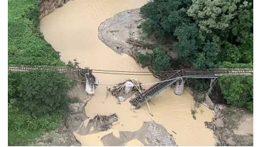
JR東日本・米坂線 橋梁倒壊 (山形県西直腸郡飯豊町)
