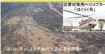
【令和元年 東日本台風】 (長野県長野市上空)
