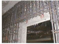
処理場の耐震化 (躯体補強)
