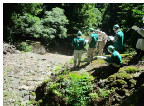
砂防設備点検(岐阜県)
