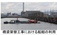
橋梁架替工事における船舶の利用
