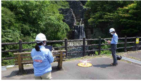
ドローンとSMARTSABOを用いた定期巡視点検の様子 (四国地方整備局)
