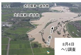
【遊水地への湛水状況（令和4年8月4日）】
