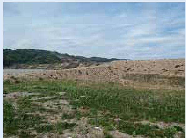
宮古市 金浜防潮堤 (嵩上げ盛土状況)
