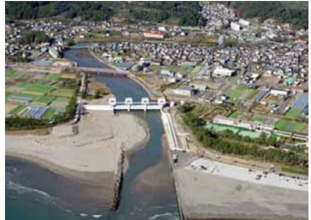
地震・津波対策（勝間田川水門）（牧之原市）
