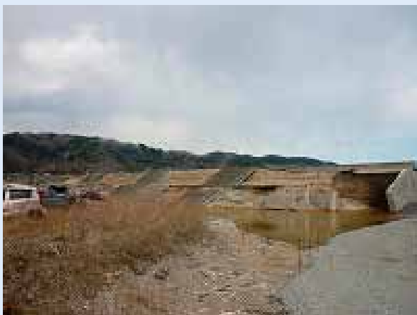
宮古市 金浜防潮堤 (震災後)
