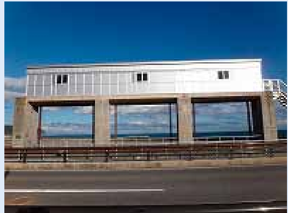
野田村 明内川水門 (復旧後)
