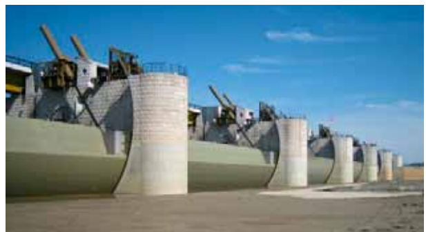
完成した新可動堰
