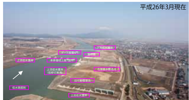
完成した可動堰改築事業全体
