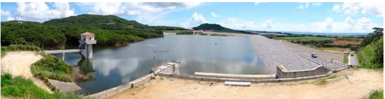
儀間ダム試験湛水の状況
