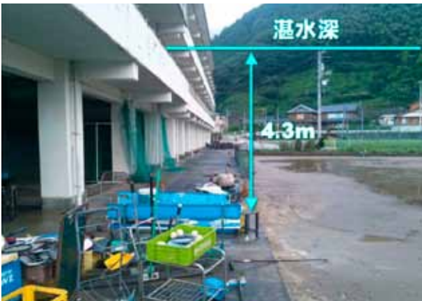
平成 26 年台風 11 号浸水状況 (加茂谷中学校)
