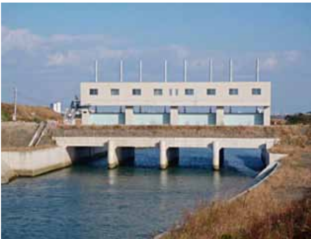
飯尾川第 2 樋門 (平成 23 年竣工)
