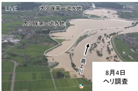
【遊水地への湛水状況(令和4年8月4日)】
