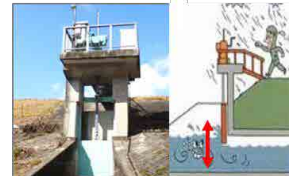
モーターでゲートを上下に開閉
