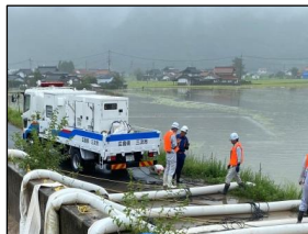
排水施設の整備
