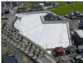
雨水貯留浸透施設の整備、改良
