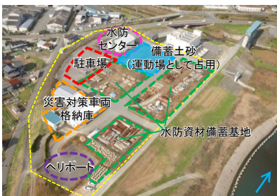
河川防災ステーションの上面レイアウト例(備蓄土砂の上面のみ平常時から利用可能)
