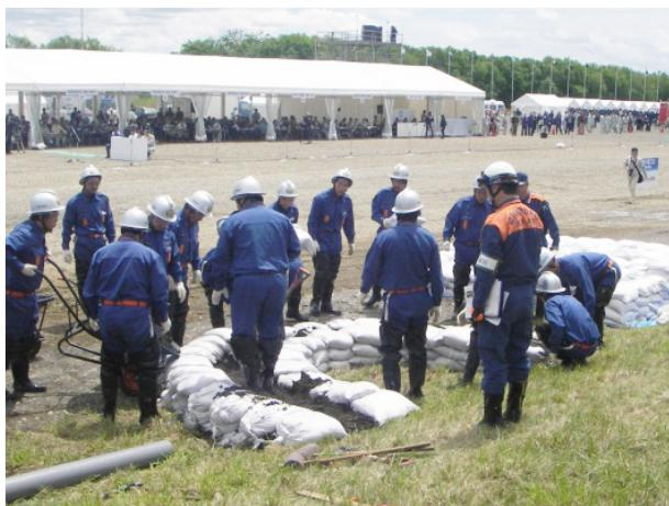
「月の輪工」による堤防の漏水対策（十勝川水系利別川総合水防演習）
