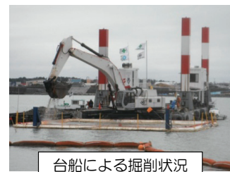
台船による掘削状況 (河口部) (H26.1)
