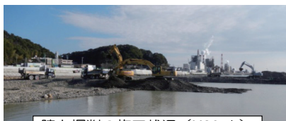
陸上掘削の施工状況 (H26.1)
