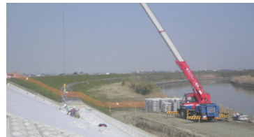
大型接続ブロック施工状況 (H26.1)
