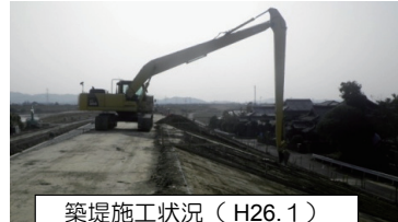
築堤施工状況 (H26.1)
