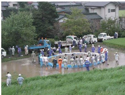
利根川における漏水状況(H13.9)
