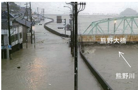
熊野川左岸 熊野大橋付近の被災状況 (三重県紀宝町)
