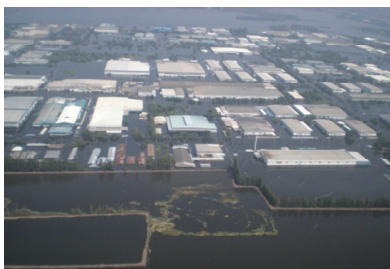
ロジャナ工業団地の浸水状況
