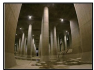
地下トンネルから流れてきた水の勢いを弱めるための調圧水槽
