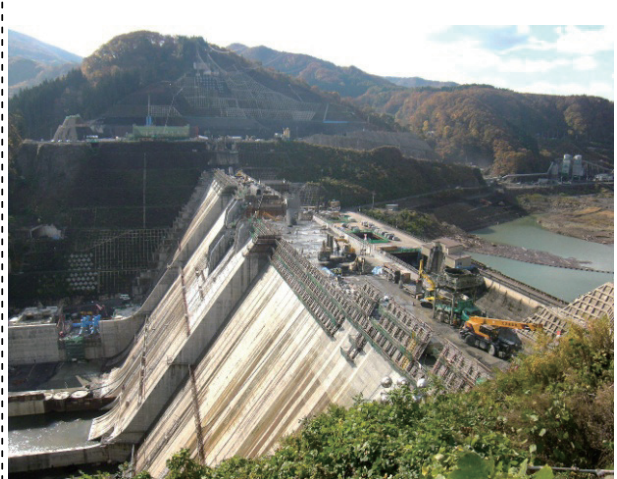
津軽ダム建設事業の施工状況(岩木川水系)
