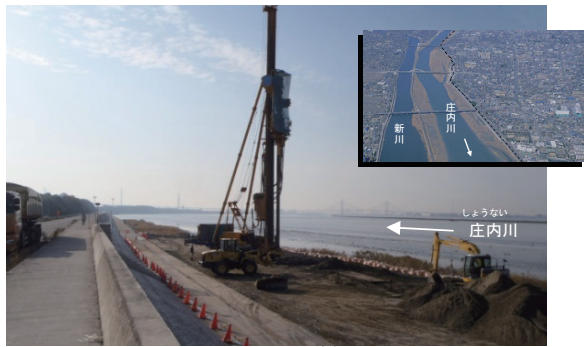
【堤防耐震化（庄内川水系）】
