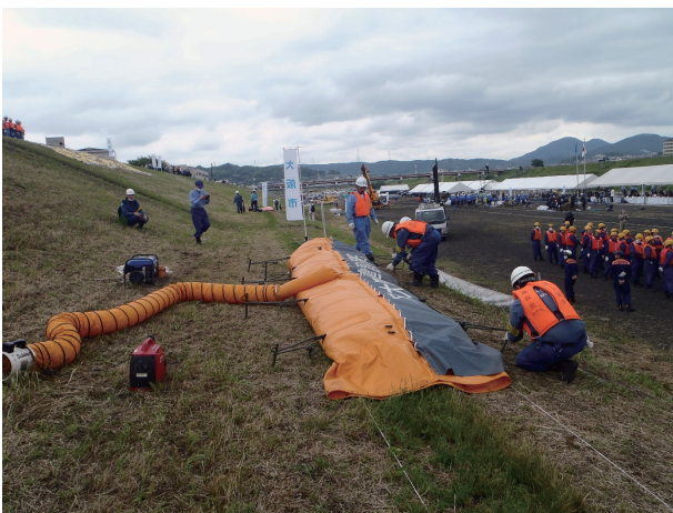
水防工法訓練(越水止め水のう工) (令和5年度 大和川水防・大阪府地域防災総合演習)
