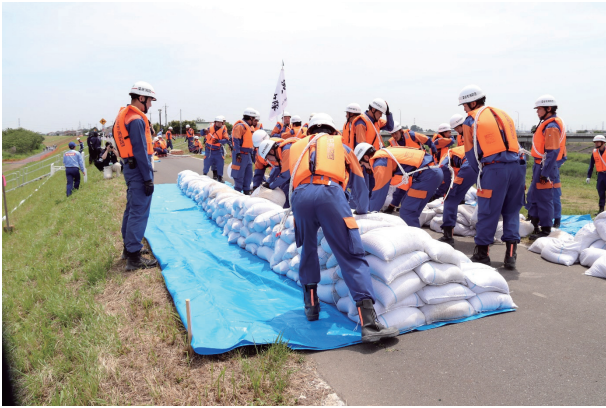
水防工法訓練(積み土のう工) (第71回 利根川水系連合・総合水防演習)
