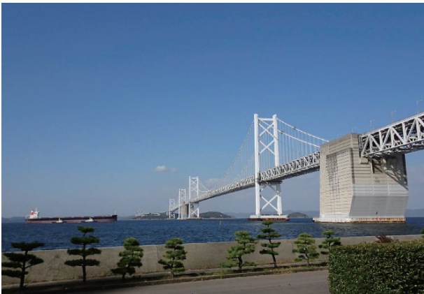
瀬戸内海と瀬戸大橋
