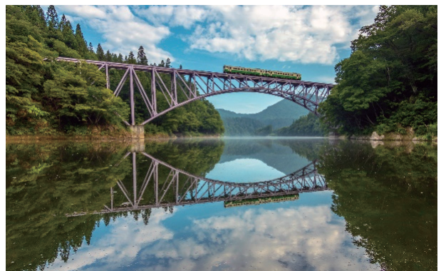
JR只見線 第一只見川橋梁(三島町)
