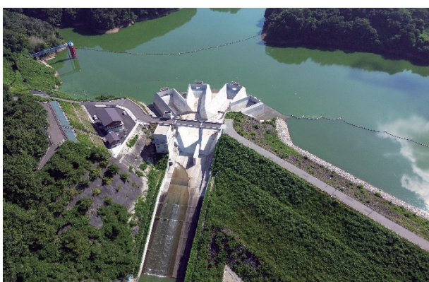
千五沢ダムの工事状況(石川町)
