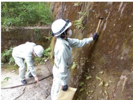
写真－6 合同砂防施設点検(打音検査)
