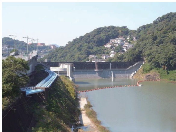
写真－3 本河内低部ダム
