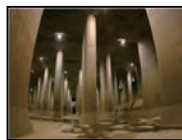
地下トンネルから流れてきた水の勢いを弱めるための調圧水槽
