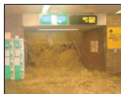
平成15年7月福岡水害による地下施設の浸水状況
