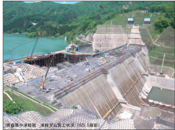
津軽ダム建設事業の施工状況 (岩木川水系)
