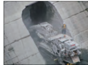
②ダム本体削孔
