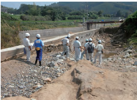
山家川（美作市）被災状況
