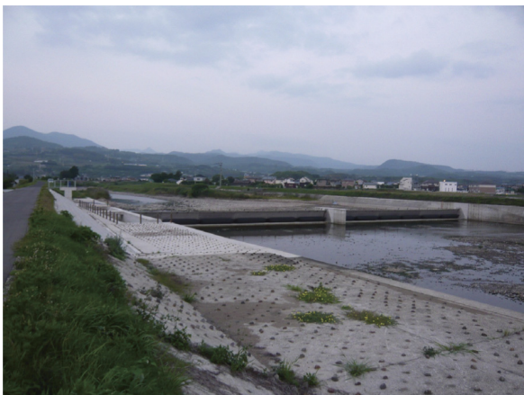
河川改修の状況(2級河川郡川)
