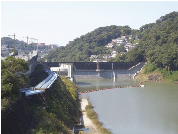
平成 24 年度に完成した本河内低部ダム
