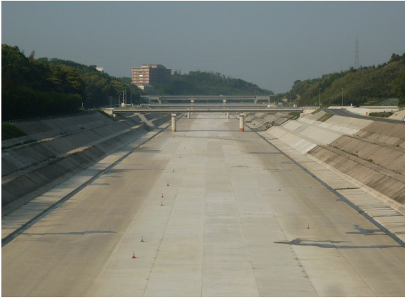
③斐伊川放水路（開削部）
