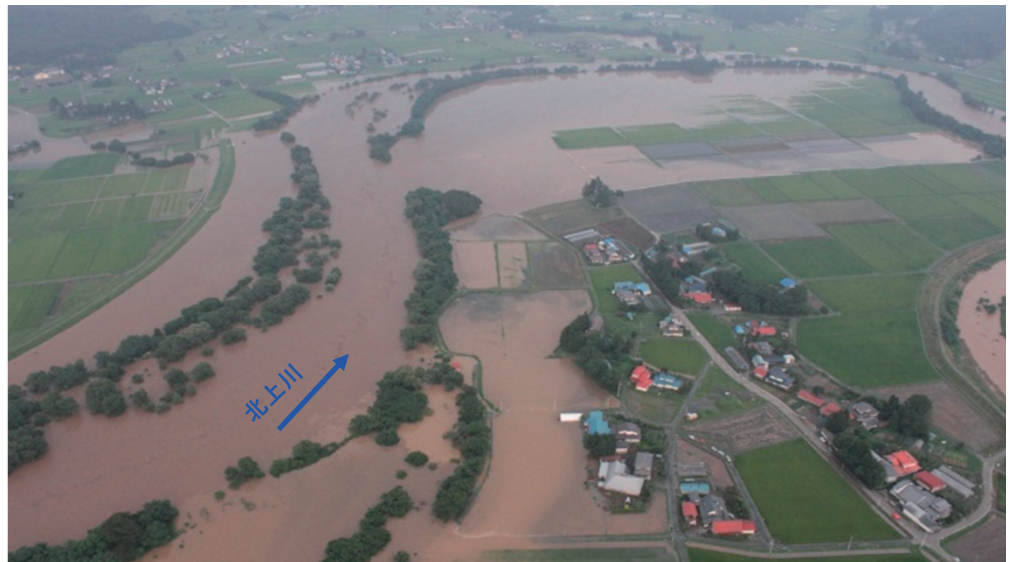
岩手県紫波町 北上川水系北上川 氾濫状況
