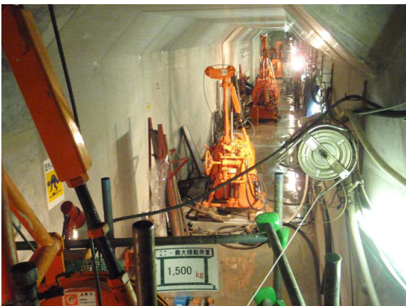
<写真-4> 基礎処理施工状況
