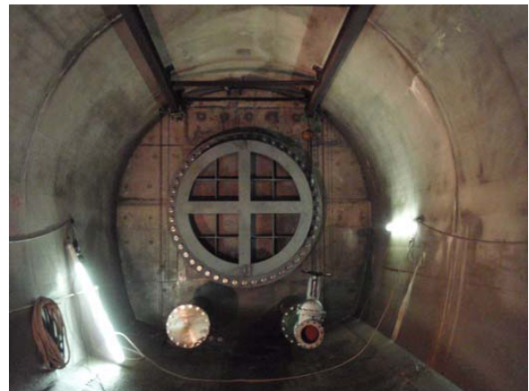
<写真-6> 堤外仮排水路（閉塞後）
