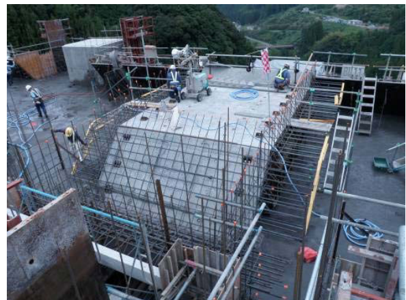
<写真-3> 常用洪水吐きのプレキャスト工法
