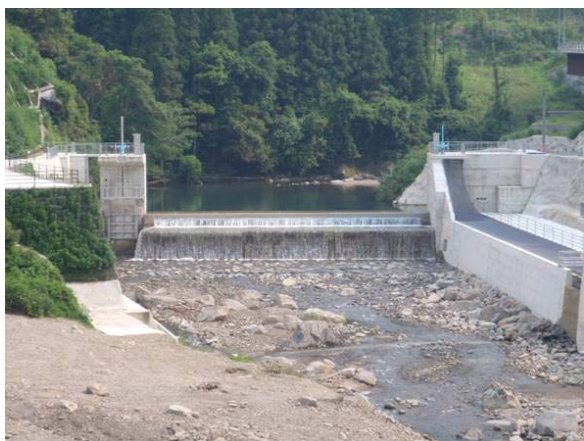
<写真-8> 流入水バイパス取水堰
