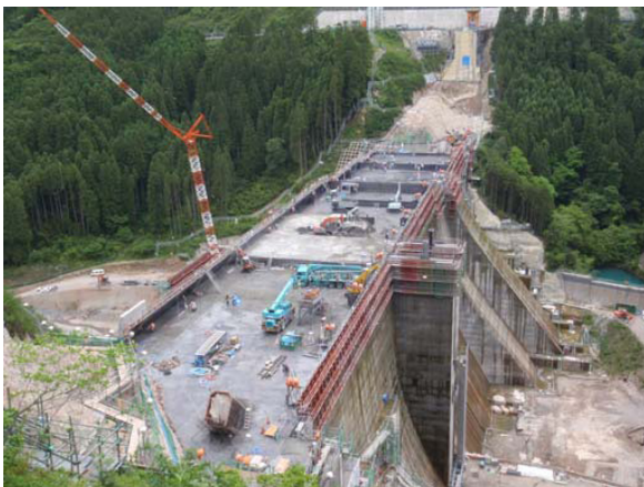
<写真-2> 堤体施工状況
