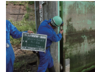
ゲート設備の点検・整備
