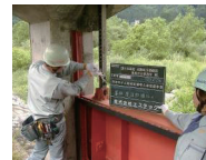
樋管ゲートの点検
