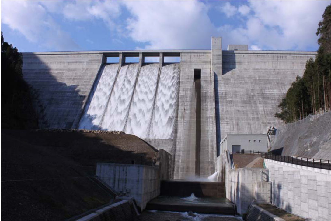
<写真-1> 試験湛水中の放流試験
