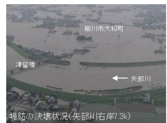
写真 8 柳川市大和町六合 堤防決壊
