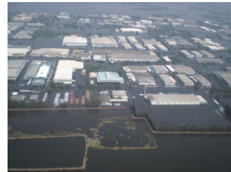
平成23年9月チャオプラヤ川(タイ) ロジアナ工業団地の浸水
