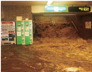
平成15年7月 地下鉄博多駅の浸水
