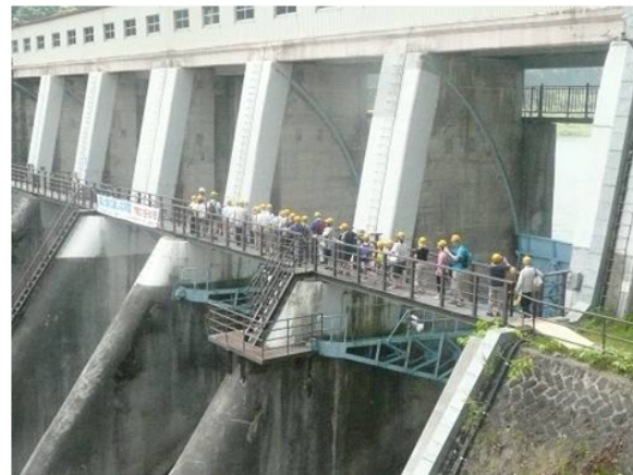
石淵ダム・胆沢ダムふれあい祭：石淵ダム堤体見学 (石淵ダム：岩手県奥州市)
