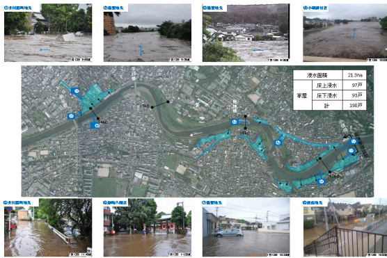
図-4 浸水被害の状況 (国管理区間)
