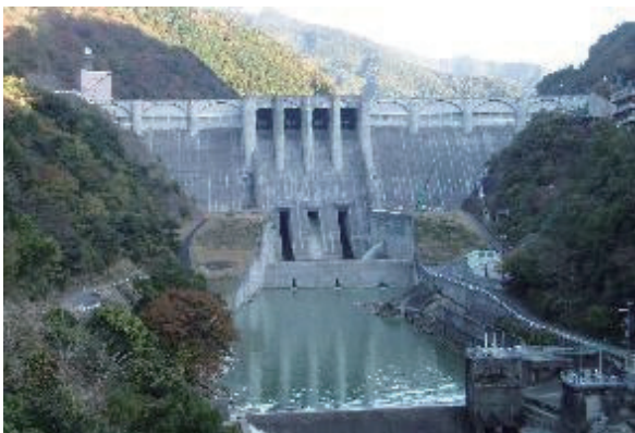
ダム堤体下流側（平成 23 年 11 月 22 日撮影）
