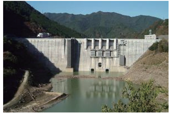
ダム堤体上流側（平成 23 年 11 月 22 日撮影）
