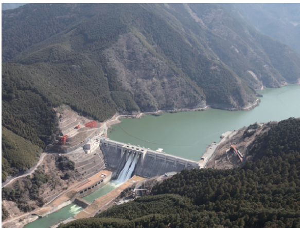
<写真-1> 試験湛水時サーチャージ水位到達 (平成 24 年 3 月 30 日.)
