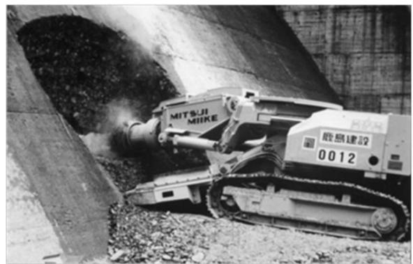
写真 4 鑑畑ダムの利水放流管増設工事
