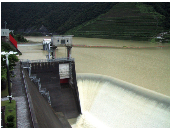
非常用洪水吐からの放流（7月30日）
