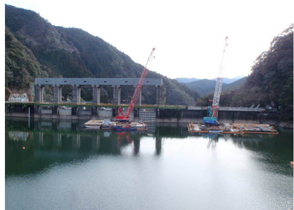
H25.1 時点の施工状況
