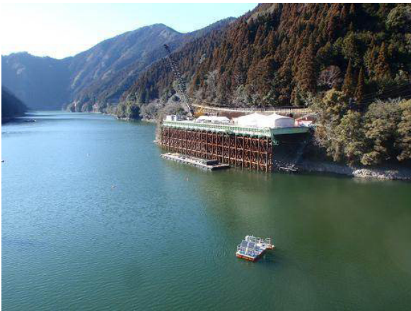
貯水池に設置した仮設構台上での起工式
