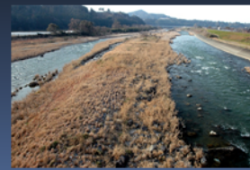
中甲橋直下流に現存する沈み塘
