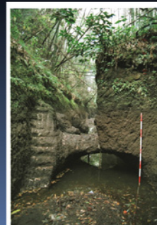
現存する第1基目鼻線り
