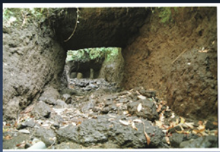
第11基目鼻線り 水路床高の測定場所
