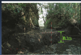
本水路と分水路の分岐点
