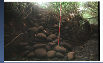
玉石による分水路右岸の補強
