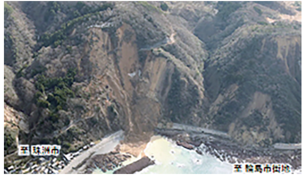
国道249号法面崩落
