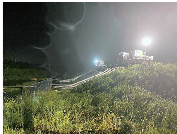
排水ポンプ車による排水活動（鳥取県倉吉市）
