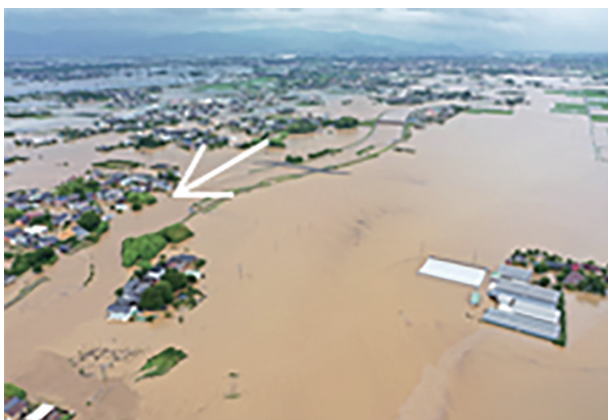
筑後川水系巨瀬川の浸水状況（福岡県久留米市）
