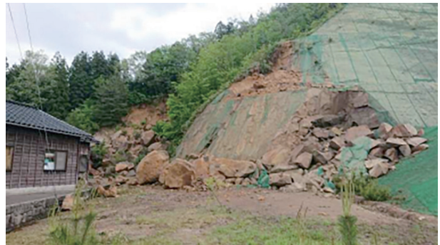
がけ崩れによる被害（石川県珠洲市正院町）
