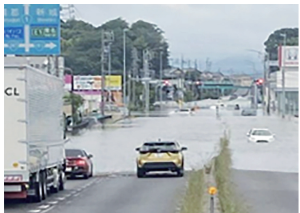
国道1号の浸水（愛知県豊川市）
