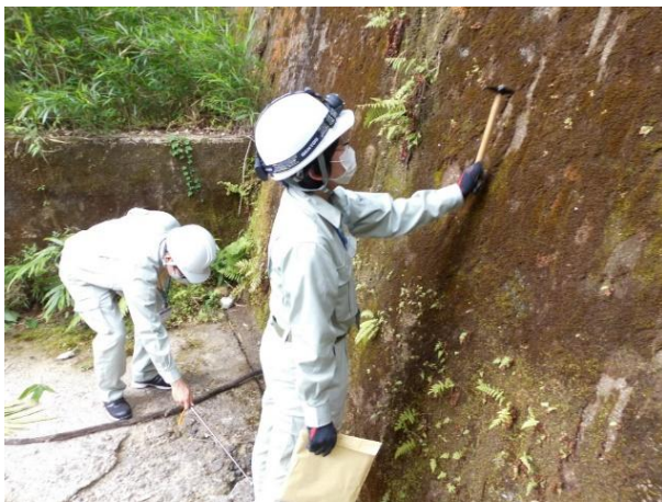
写真－5 令和5年度土砂災害防止月間における砂防施設点検（岐阜県 土岐市）
