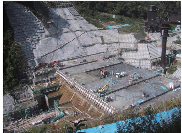
ダム本体コンクリート打設量 52,000m<sup>3</sup>
