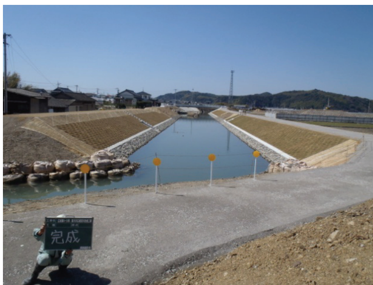
新川川 河川改修の状況
