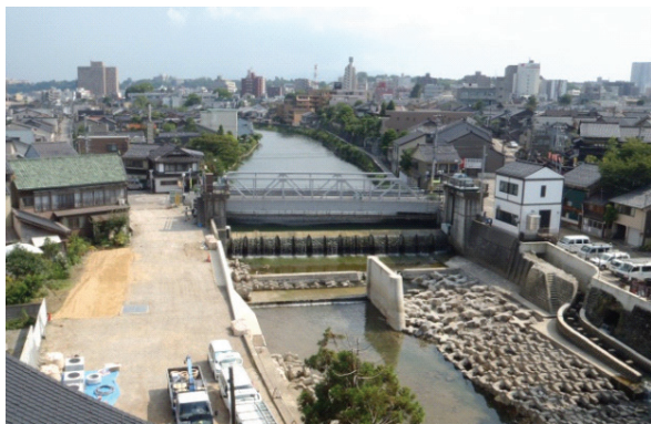
浅野川小橋用水堰の改修状況
