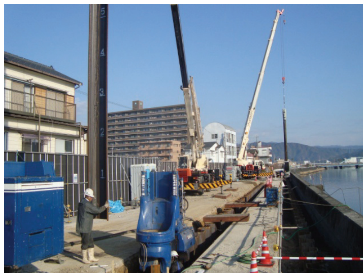
国分川 河川堤防耐震化工事
