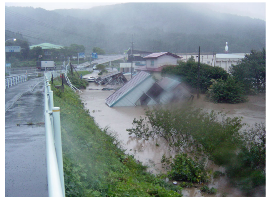
写真－ 5 被害状況（能代市二ツ井町小繋地区）
