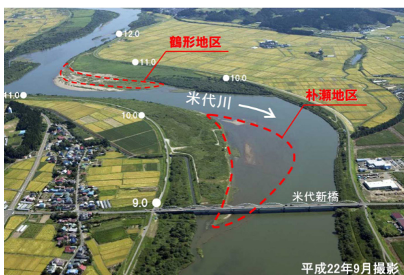
写真－8 河道掘削（能代市朴瀬～鶴形地区）
