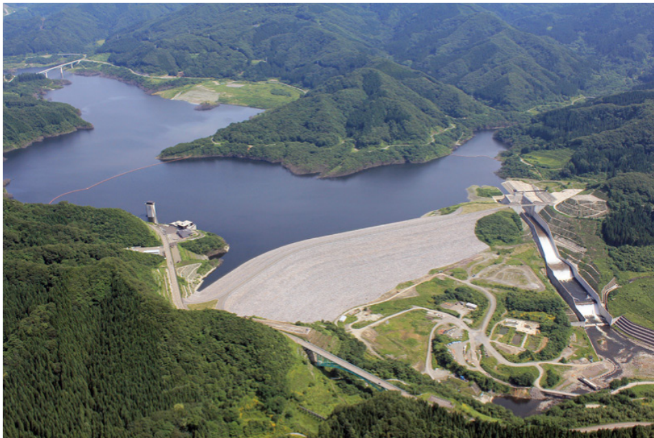
写真－ 12 森吉山ダム（平成 24 年 3 月竣工）
