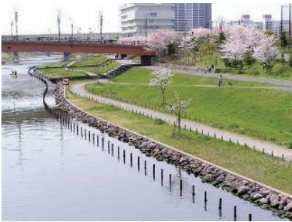
堤内地との一体化を図った整備
