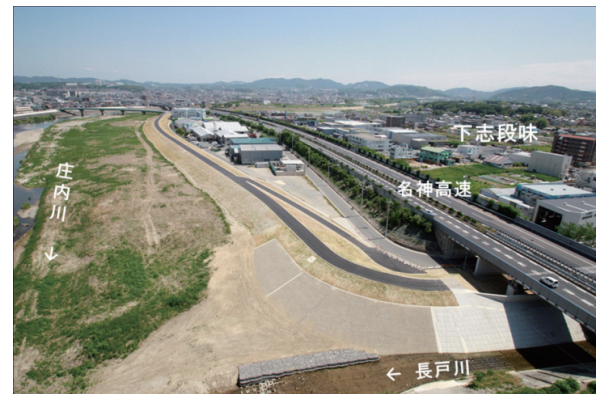
完成した下志段味地区の堤防
