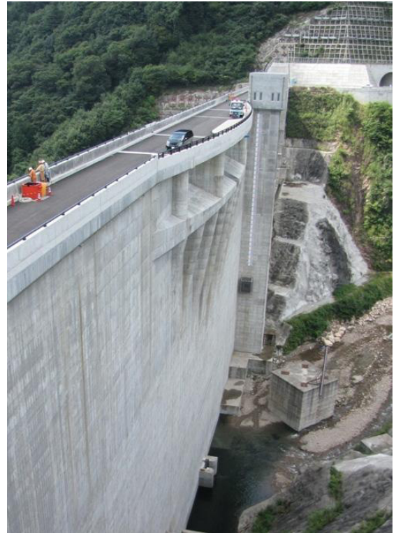
ダム天端の展望スペース（試験湛水前）
