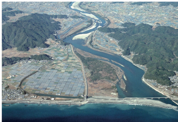
工事着手前（昭和 62 年 12 月撮影）
