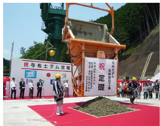
タワークレーンで運ばれたコンクリートの投入
