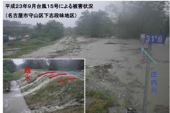
庄内川本川からの越水状況（平成 23 年 9 月 20 日）
