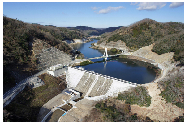
最高水位保持状況（平成 24 年 1 月 12 日撮影）
