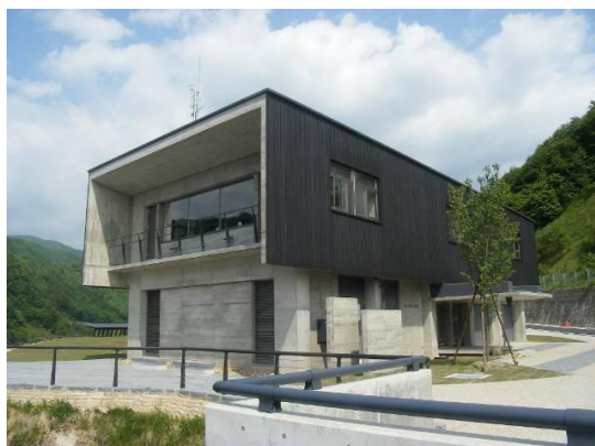
丹生川ダム管理所
