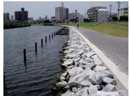
水際部の自然石を用いた護岸
