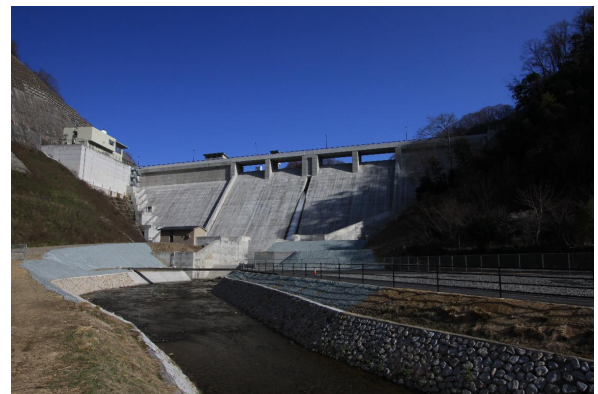
ダム堤体（下流より望む）
