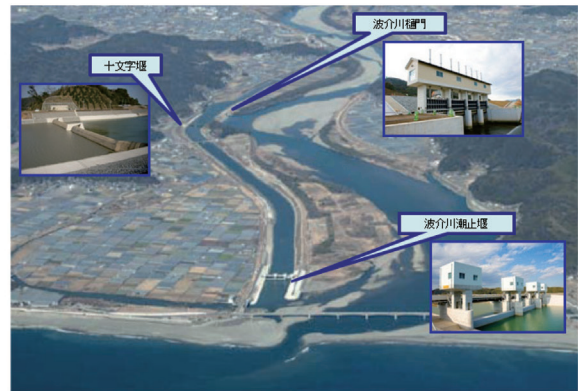
工事完了間近（平成 24 年 3 月撮影）
