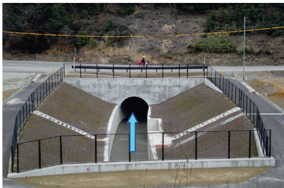
開削水路部 (トンネル中間)
