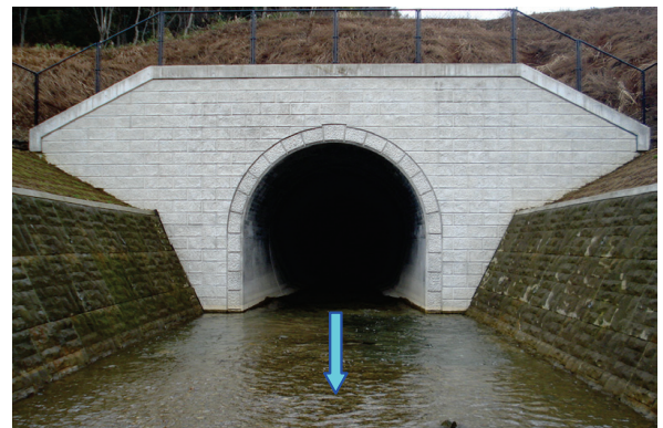
坑口部 (下流トンネル)
