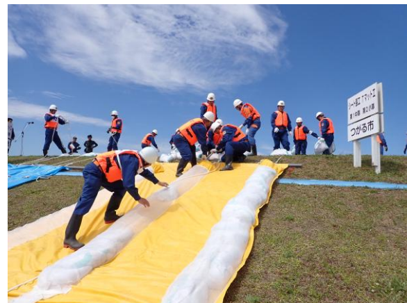
水防工法訓練(水防マット工) (岩木川総合水防演習)
