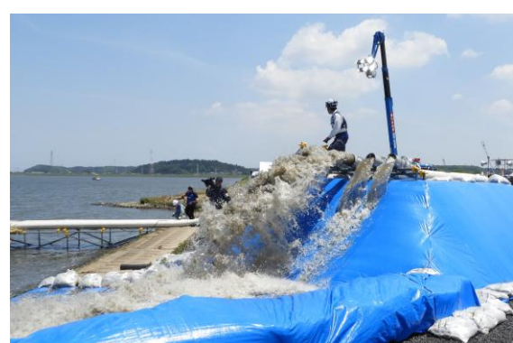
排水作業訓練 (第72回利根川水系連合・総合水防演習)
