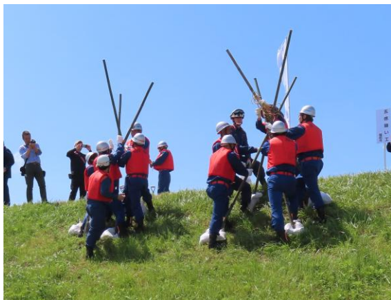
水防工法訓練(五徳縫い工) (九頭竜川水系総合水防演習)
