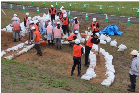
大学生による水防工法訓練(月の輪工) (三重四川連合総合水防演習)
