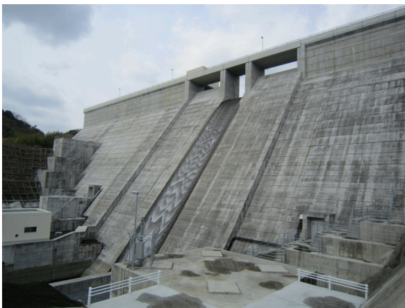
黒杭ダム上流ダム堤体
