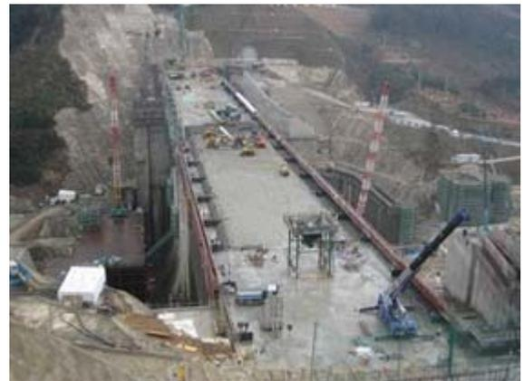
巡航 RCD 工法打設状況
