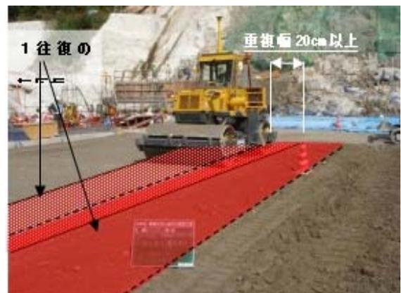
副ダム GPS による情報化施工 (CSG 転圧状況)
