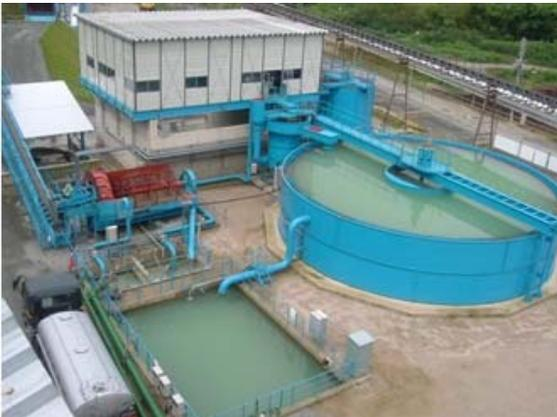
骨材製造濁水処理設備（通常の1/3程度）
