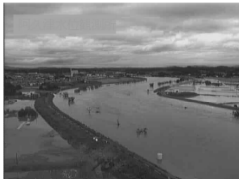
阿武隈川阿久津地点の出水状況
