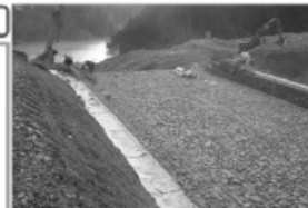
仮橋水路施工状況 (奈良県十津川村長殿)
