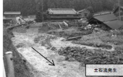
三重県津市 所谷川
