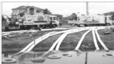
各地方整備局から集結した排水ポンプ車の活動状況
