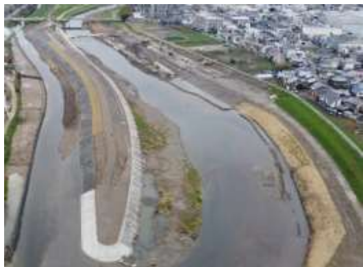
京都市鴨川整備状況（伏見区）
