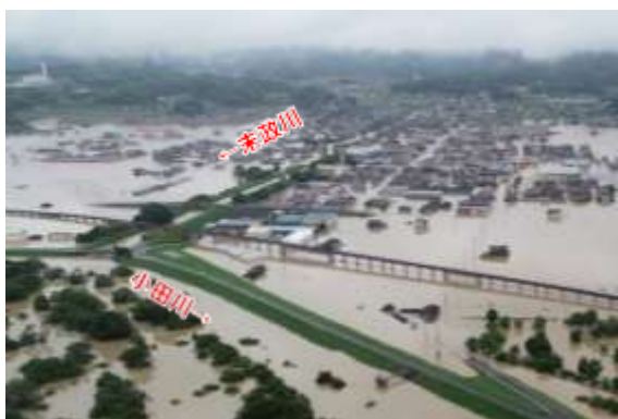
平成30年7月豪雨の浸水状況（倉敷市真備町）
