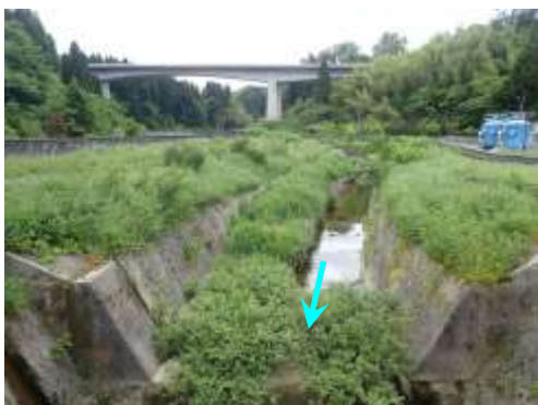
堆積土砂除去の事例（涌波川：金沢市）
