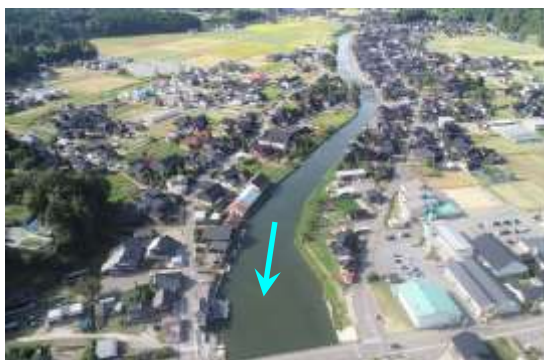
河川改修の事例（熊木川：七尾市）
