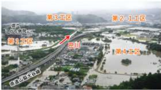
ほぼ満水状態となった麻機遊水地（静岡市）
