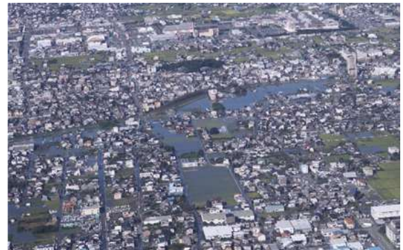
安間川流域の浸水状況（浜松市）
