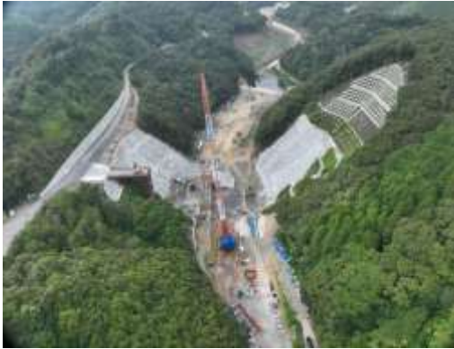
建設中の春遠第1ダム
