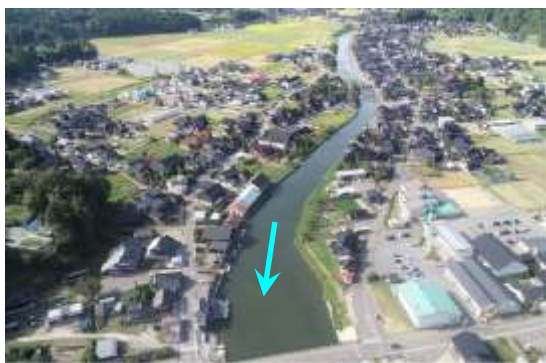
河川改修の事例（熊木川：七尾市）
