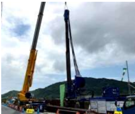
耐震対策工事の状況（高知市・下田川）
