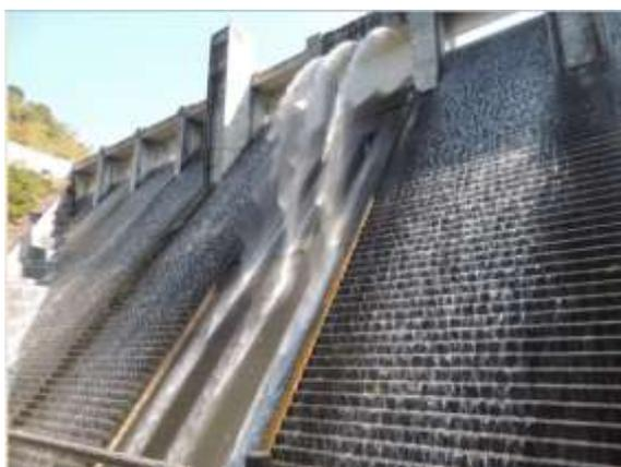
洗浄放水状況（中筋川ダム）
