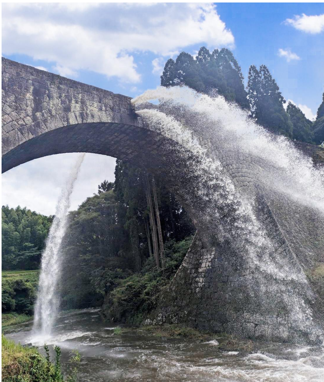
通潤橋（つうじゅんきょう）熊本県上益城郡山都町
