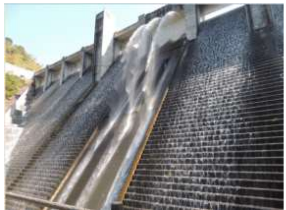
洗浄放水状況（中筋川ダム）
