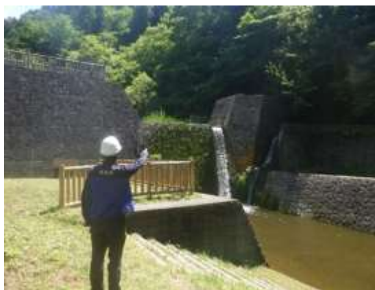
砂防堰堤の設備点検（青森県中泊町）
