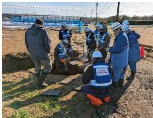
関係機関と連携した水道の被災箇所確認
